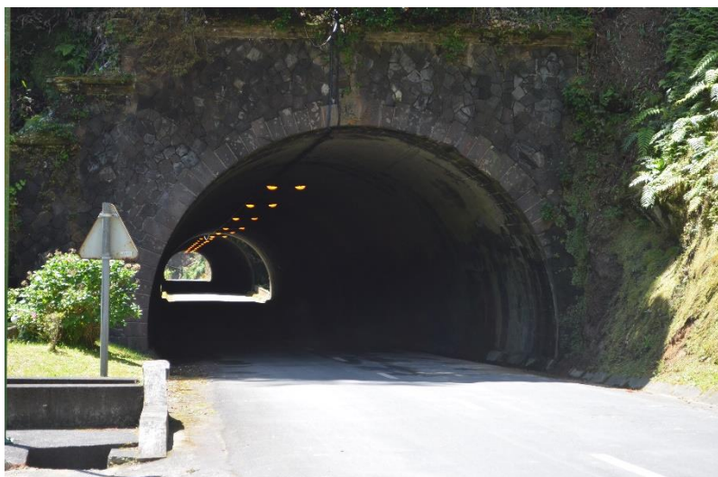
Figura I.14 - Túnel de acesso à freguesia da Ribeira Quente (fotografia: SMPC-PVC).
