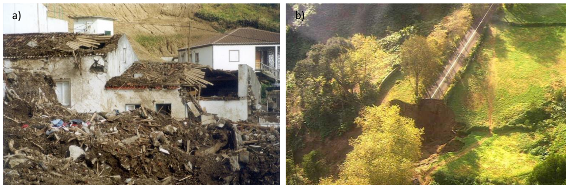
Figura I.9 - Exemplos da destruição provocada pelos movimentos de vertente ocorridos a 31 de outubro de 1997: a) casas destruídas; b) estrada cortada devido ao colapso de parte de uma linha de água no Vulcão das Furnas (fotografias IVAR).
