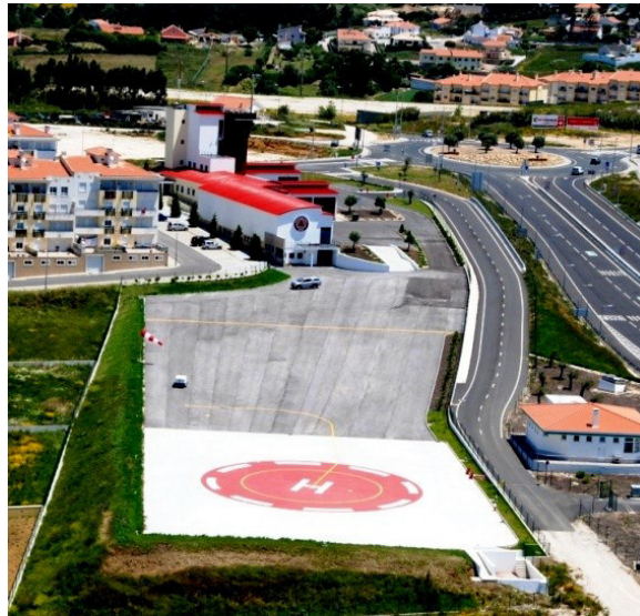
Figura 7 – Vista aérea do Heliporto Municipal
