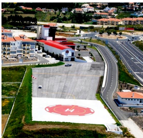
Figura 8 – Vista aérea do Heliporto Municipal
